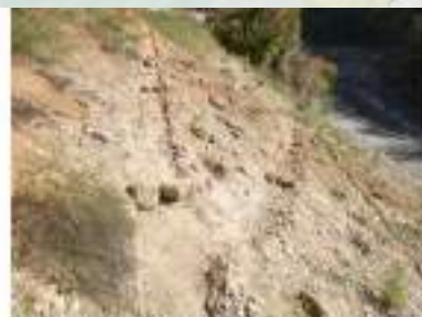
Sillons obliques pour faciliter le déplacement et limiter l'érosion
