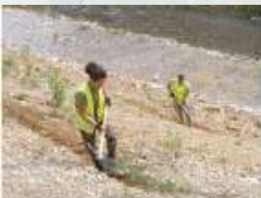
Creusement manuel de sillons pour faciliter l'accès
