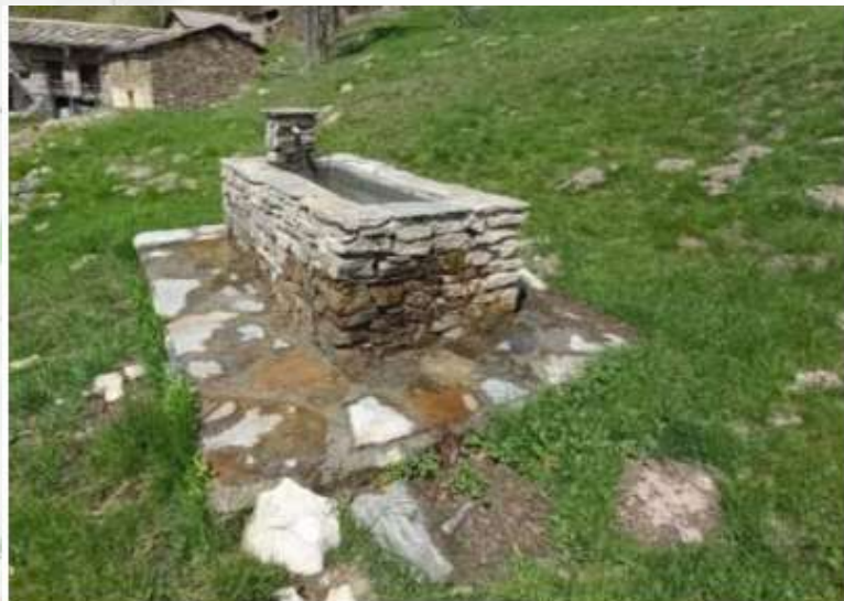
IMPERMEABILIZZAZIONE VASCA (DIMENSIONI INTERNE 150*50*65 cm)
