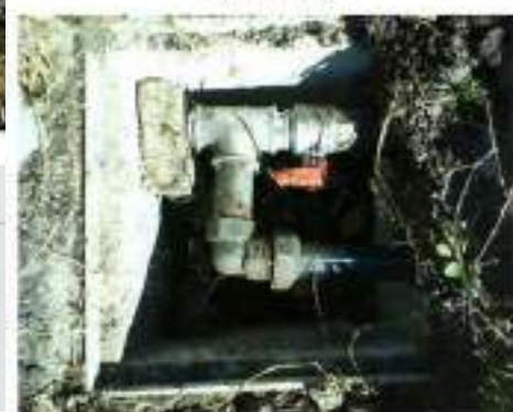
MISURO POZZETTO DI DERIVAZIONE
